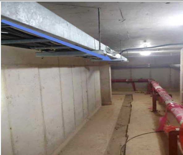
관리사무실옆 선로 설치 위치(1)
